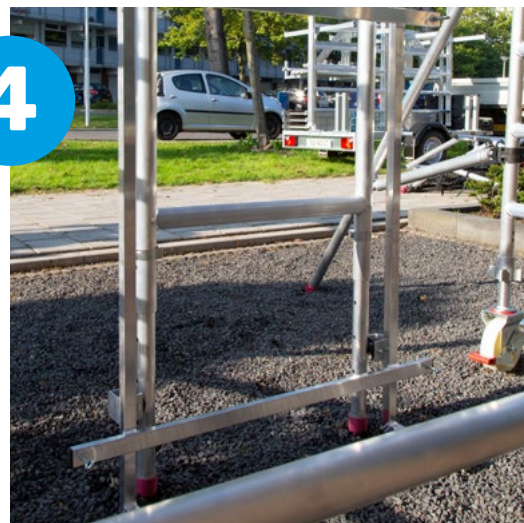
4 Die Laufkatze auf den Basis Aufzugsrahmen schieben.
