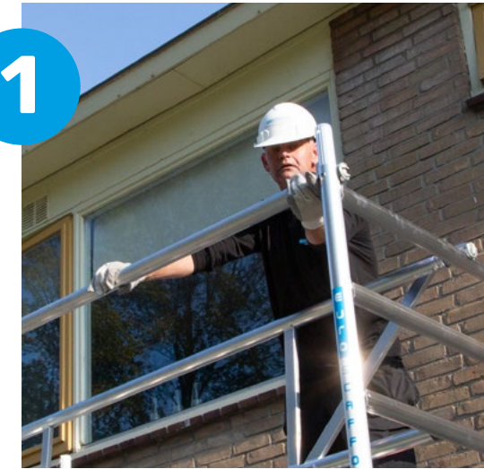
1 Den unteren Horizontalträger 3 Meter über Bodenniveau montieren.
